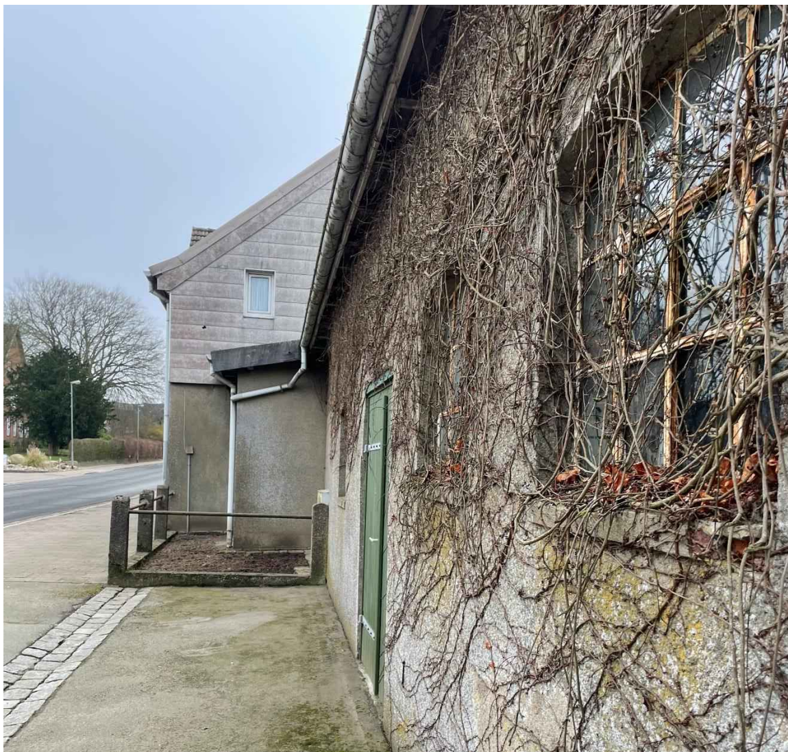
Foto 5: Blick auf das Lager mit angrenzendem Wohnhaus
