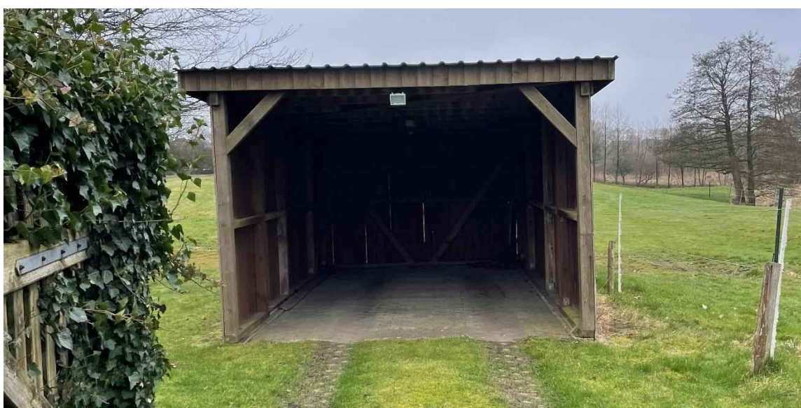
Foto 6: Blick auf das Carport
