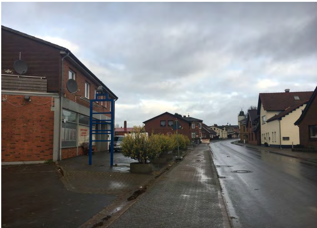
Abbildung 3: Blick entlang der Norderstraße in nördliche Richtung
