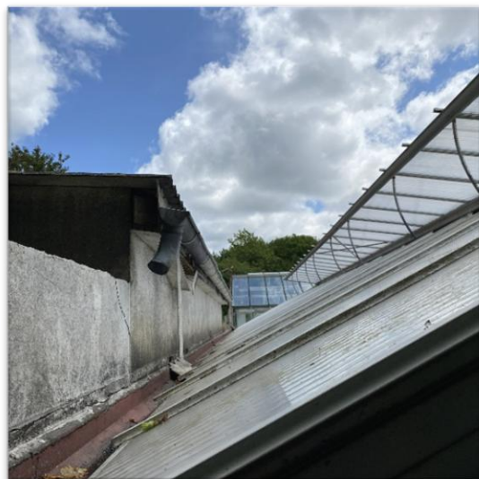
Abbildung 10.1.4: Schuppen und Gewächshaus zugänglich für Vögel und Fledermäuse (09.07.2025)
